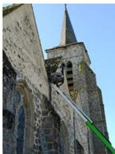
Comme nous l'avons déjà évoqué, des dégradations dans différentes parties de l'église de notre village provoquent des infiltrations récurrentes. Aussi, des défauts d'étanchéité ont été constatés notamment au niveau des chéneaux, à cause de l'accumulation de mousse et de fientes de pigeons qui obstruent les évacuations d'eau. Une première intervention, par un charpentier, a eu lieu, courant janvier, pour permettre un démoussage d'une partie du toit et des faitières.
